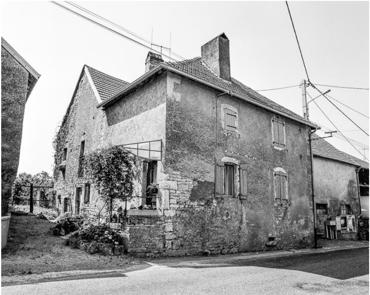
Maison située rue de Montbozon : façades antérieure et latérale droite sur la rue.
