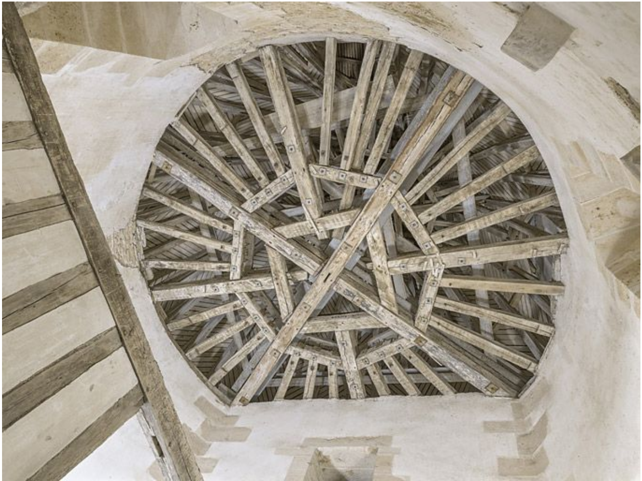
Combles : au-dessus du grand logis. Tour sud-ouest : vue de la charpente.
