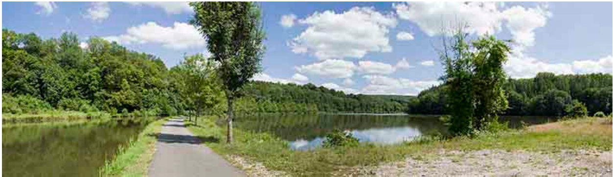
Vue en amont de l'écluse.
