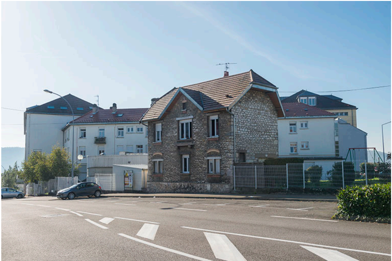
L'extrémité nord de la parcelle avec la façade nord-est du logement.
