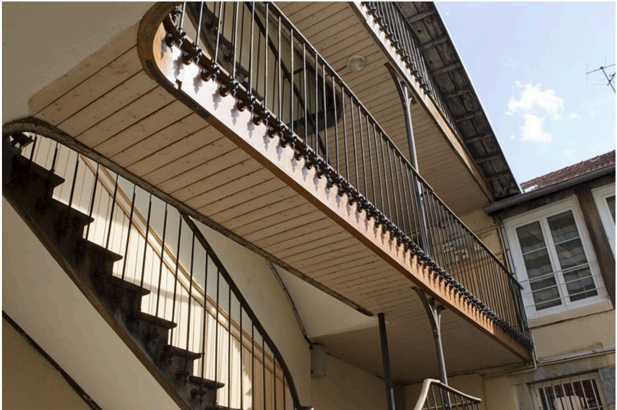
Escalier à cage ouverte sur cour : détail de la partie supérieure.
