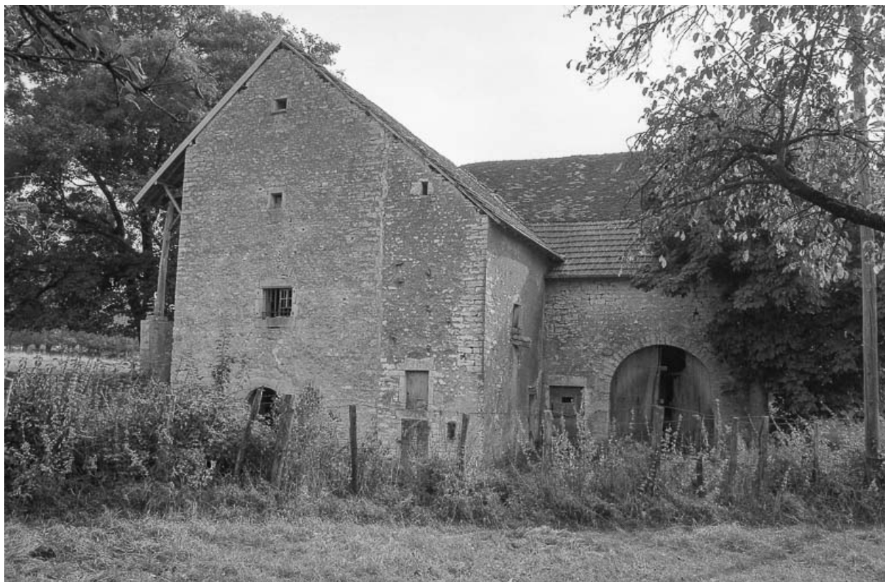
Façades sur rue.
