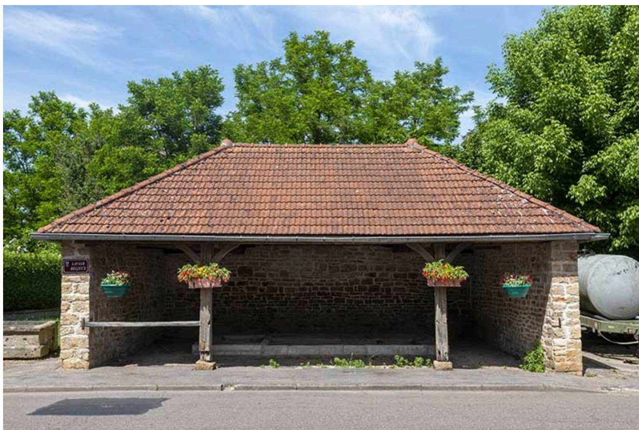
Le lavoir depuis la rue de la Libération.
