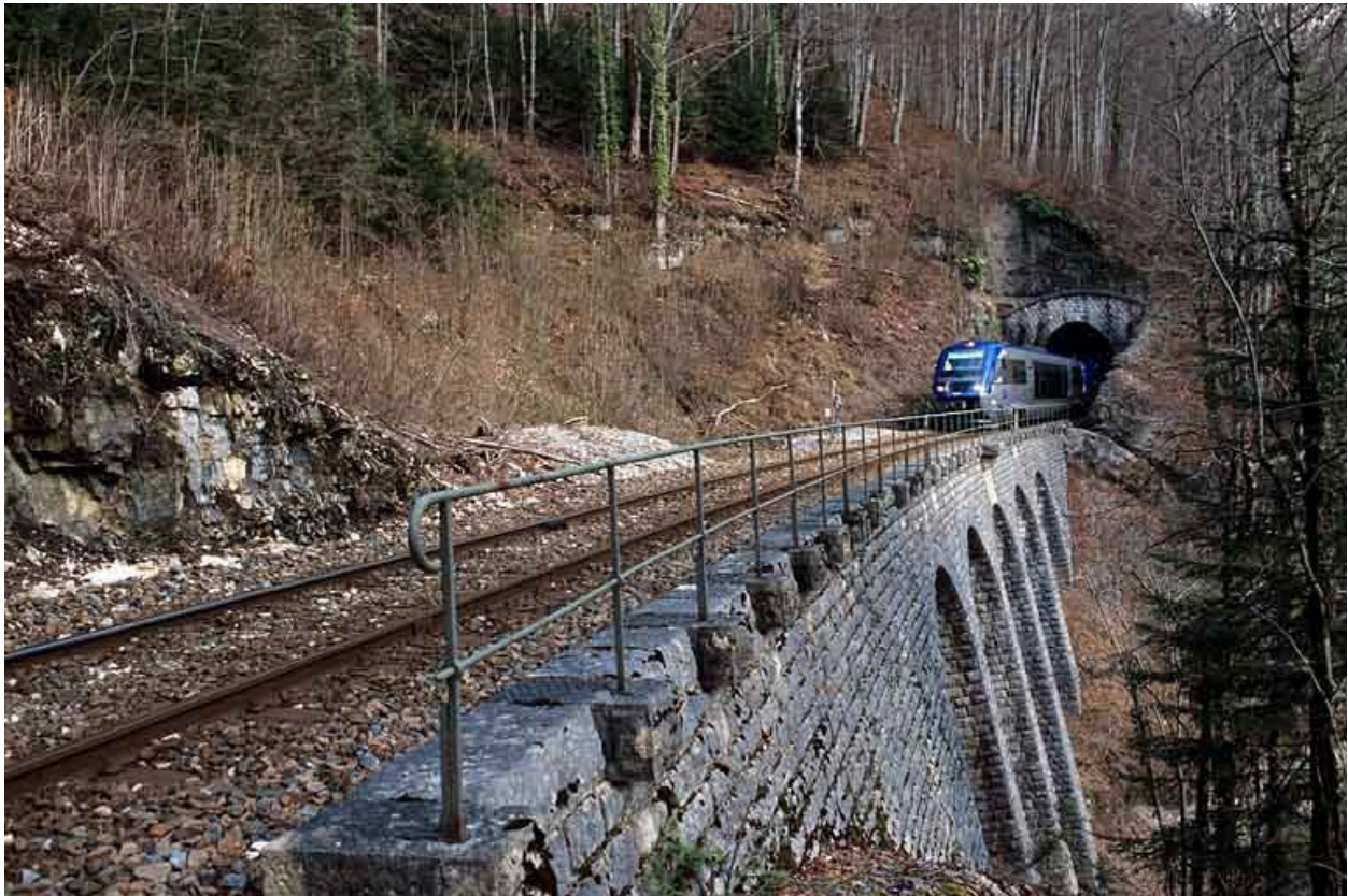
Sommet du mur, garde-corps et voie, vus en enfilade depuis le côté La Cluse (sud-ouest). Un autorail X 73500 sort du tunnel de Lézair.
