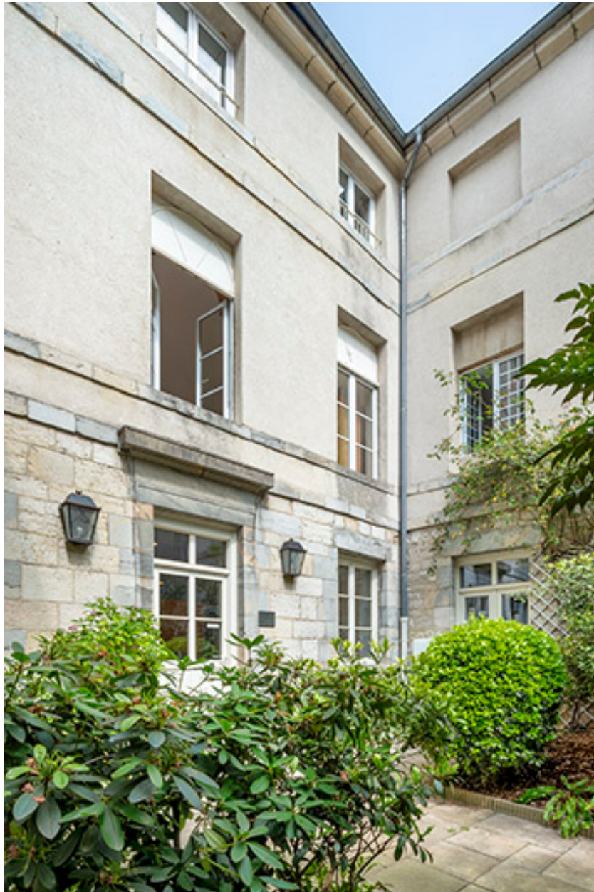
Aile sud vue depuis l'entrée.
