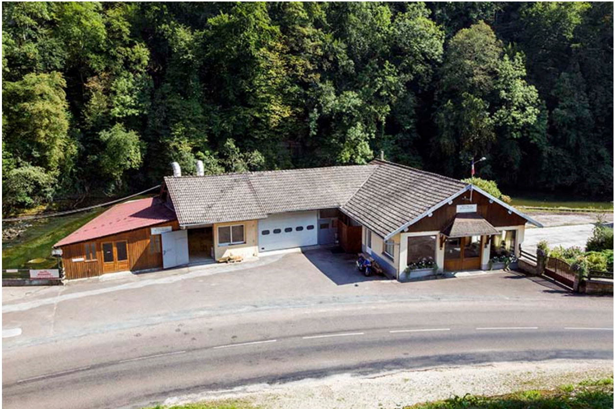
Vue plongeante sur le magasin, depuis le nord.
