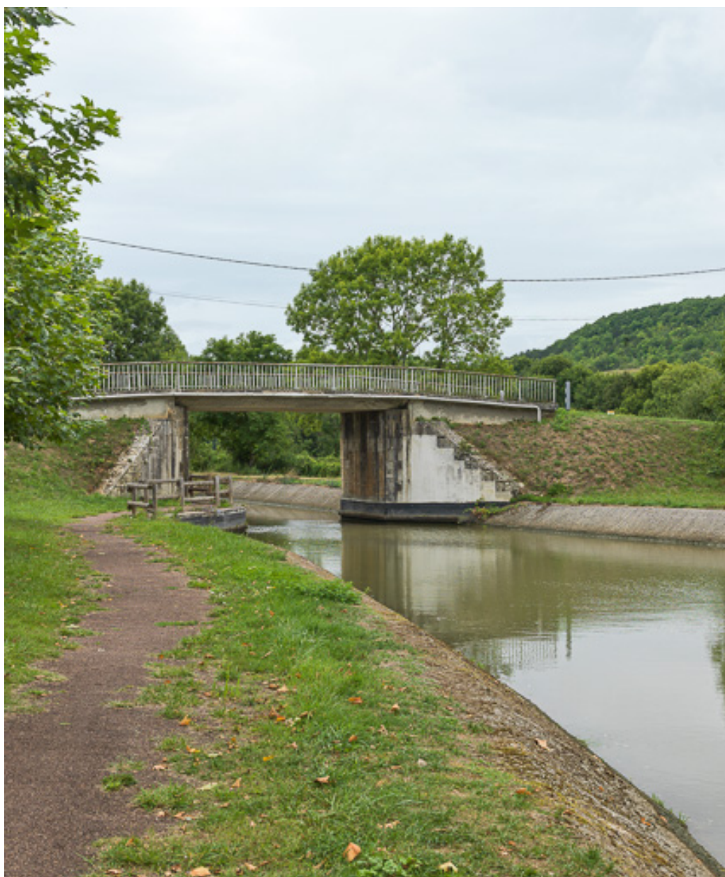
Vue d'ensemble du pont.
