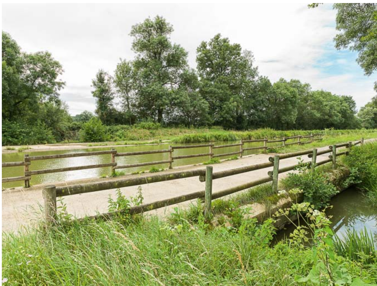
Vue du déversoir.
