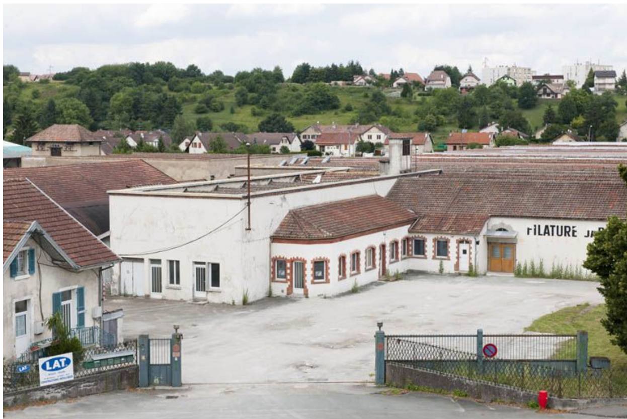
Vue d'ensemble plongeante depuis le sud.
