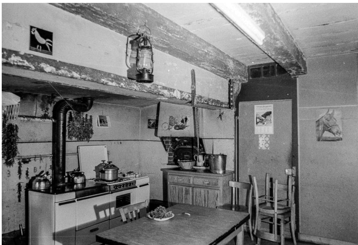
Cuisine : poutre supportant la cheminée.
