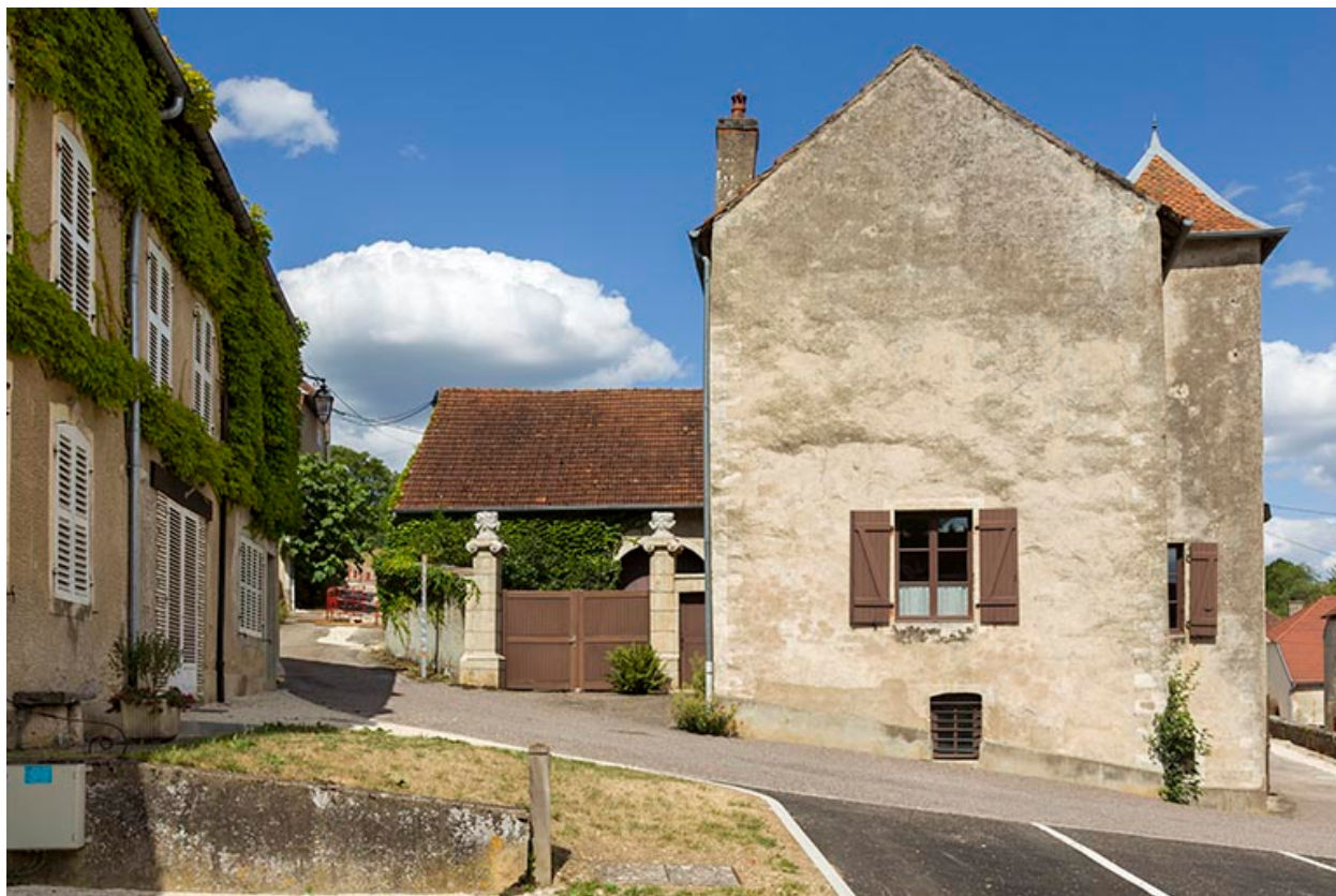
Vue générale depuis la place de l'Abondance.
