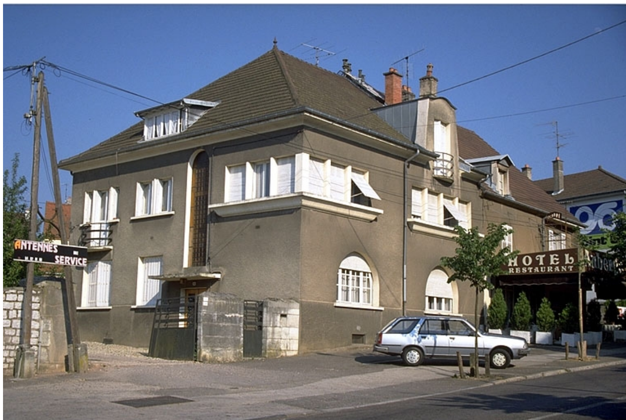
Logement patronal, vu depuis l'avenue.
