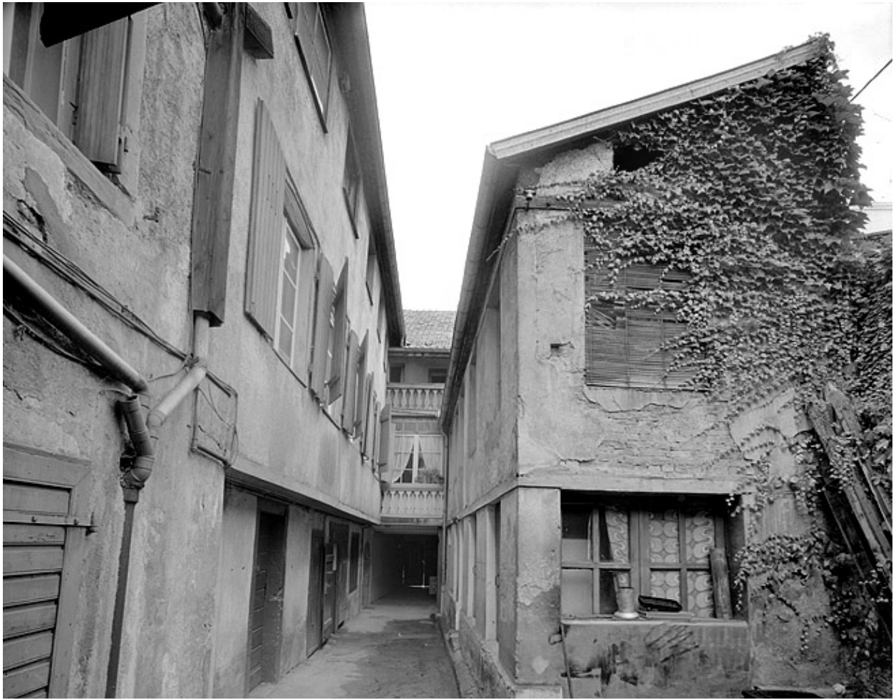
Vue d'ensemble de la cour vers le corps de bâtiment sur rue.
