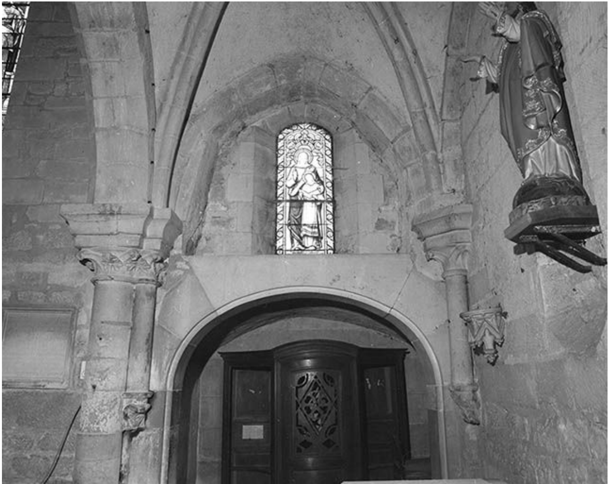
Chapelle gauche, mur gauche.
