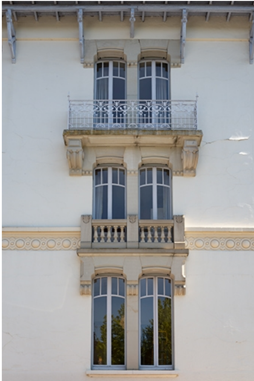
Travée de la façade ouest.
