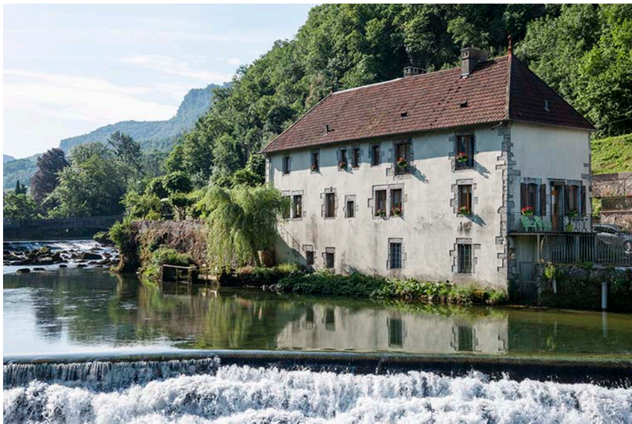
Logement d'ouvriers vu de trois quarts droite.
