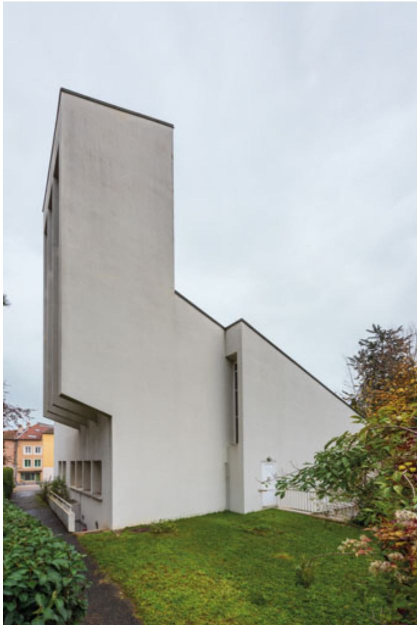
Vue de la façade ouest.
