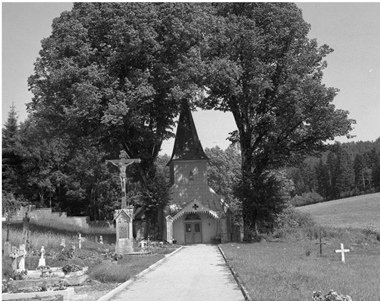
Façade antérieure et cimetière.
