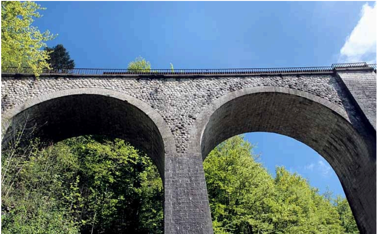
Deux arches du côté La Cluse, vues en contre-plongée.
