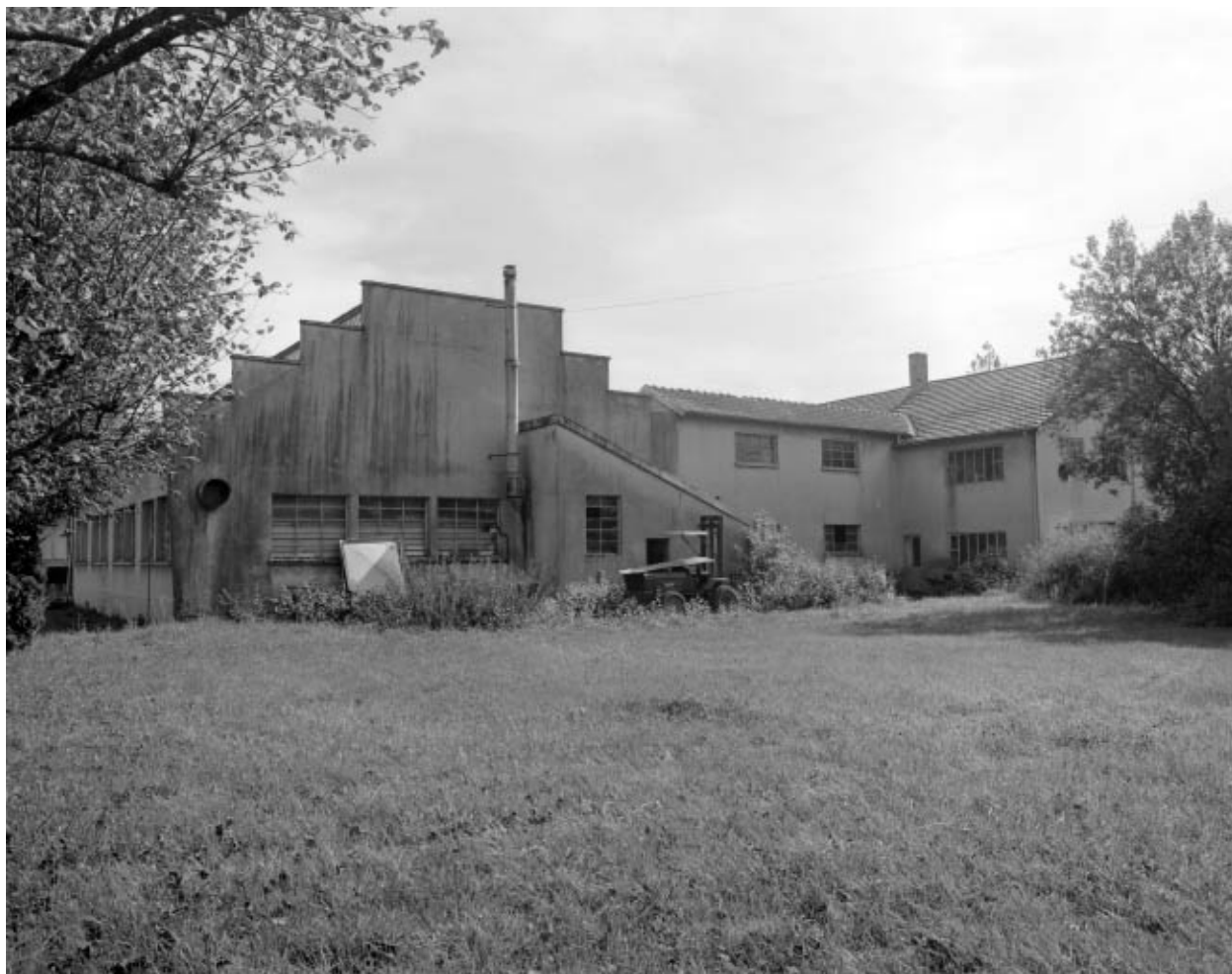
Façades postérieures des ateliers de fabrication.
