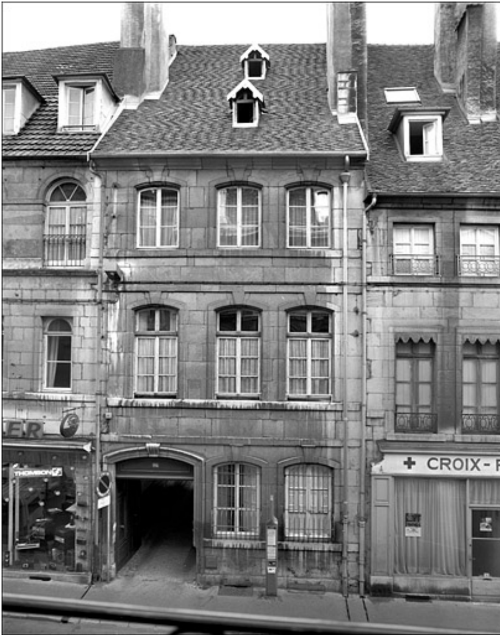
Vue d'ensemble de la façade antérieure du logis sur rue.
