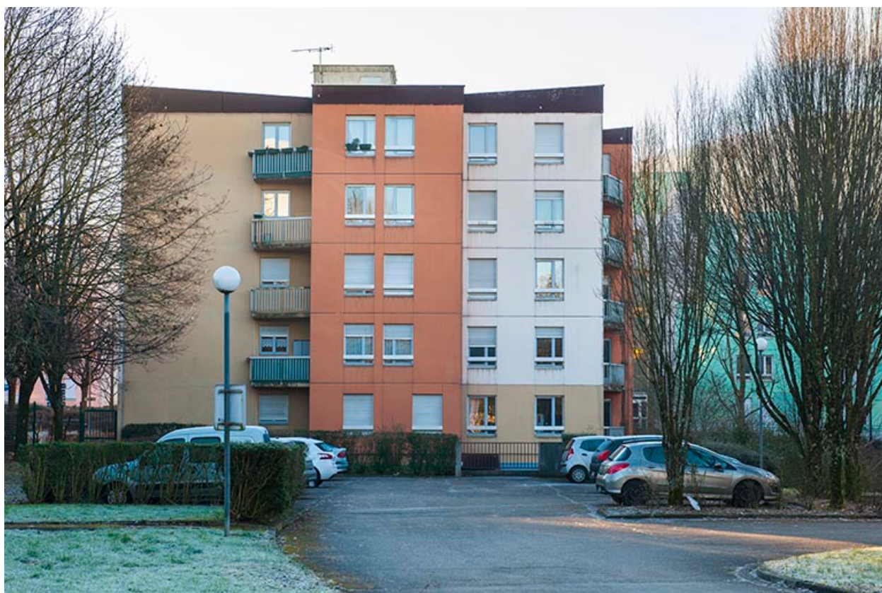
Les logements : façade nord-ouest.
