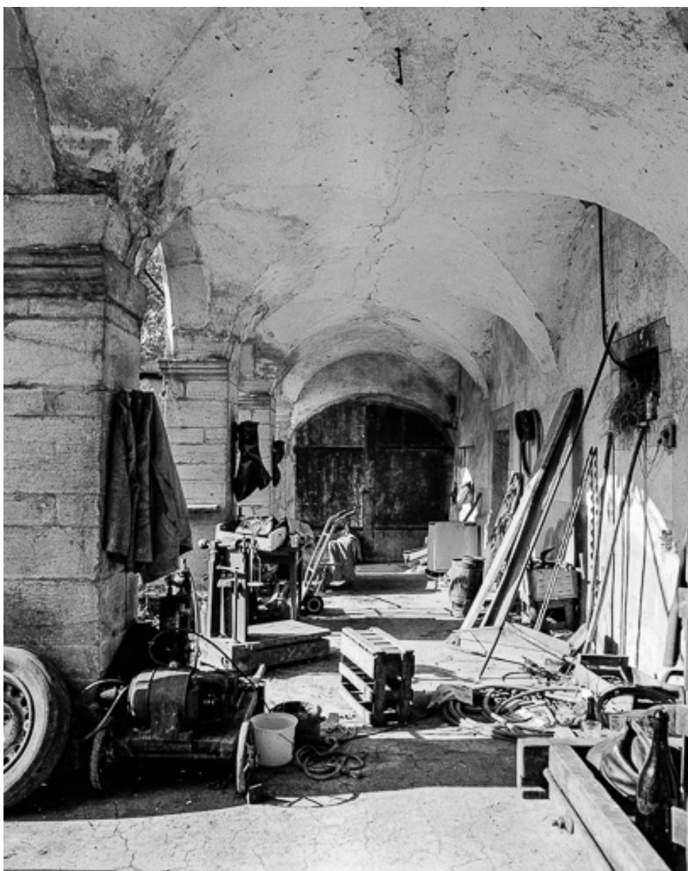
Corps de logis, rez-de-chaussée de la galerie.
