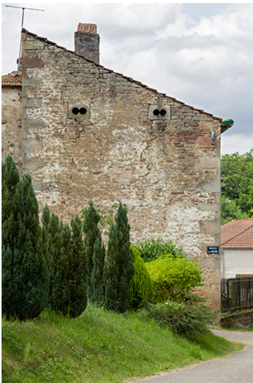
Mur pignon avec ses petits oculis.
