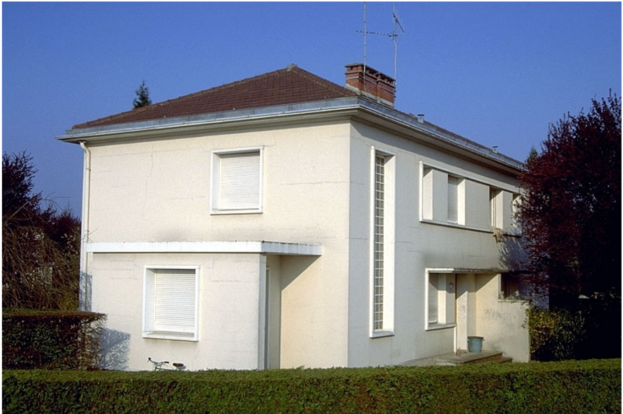
Façade antérieure et face droite.
