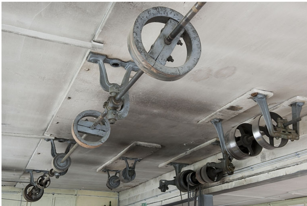
Intérieur de l'atelier. Système de transmissions.
