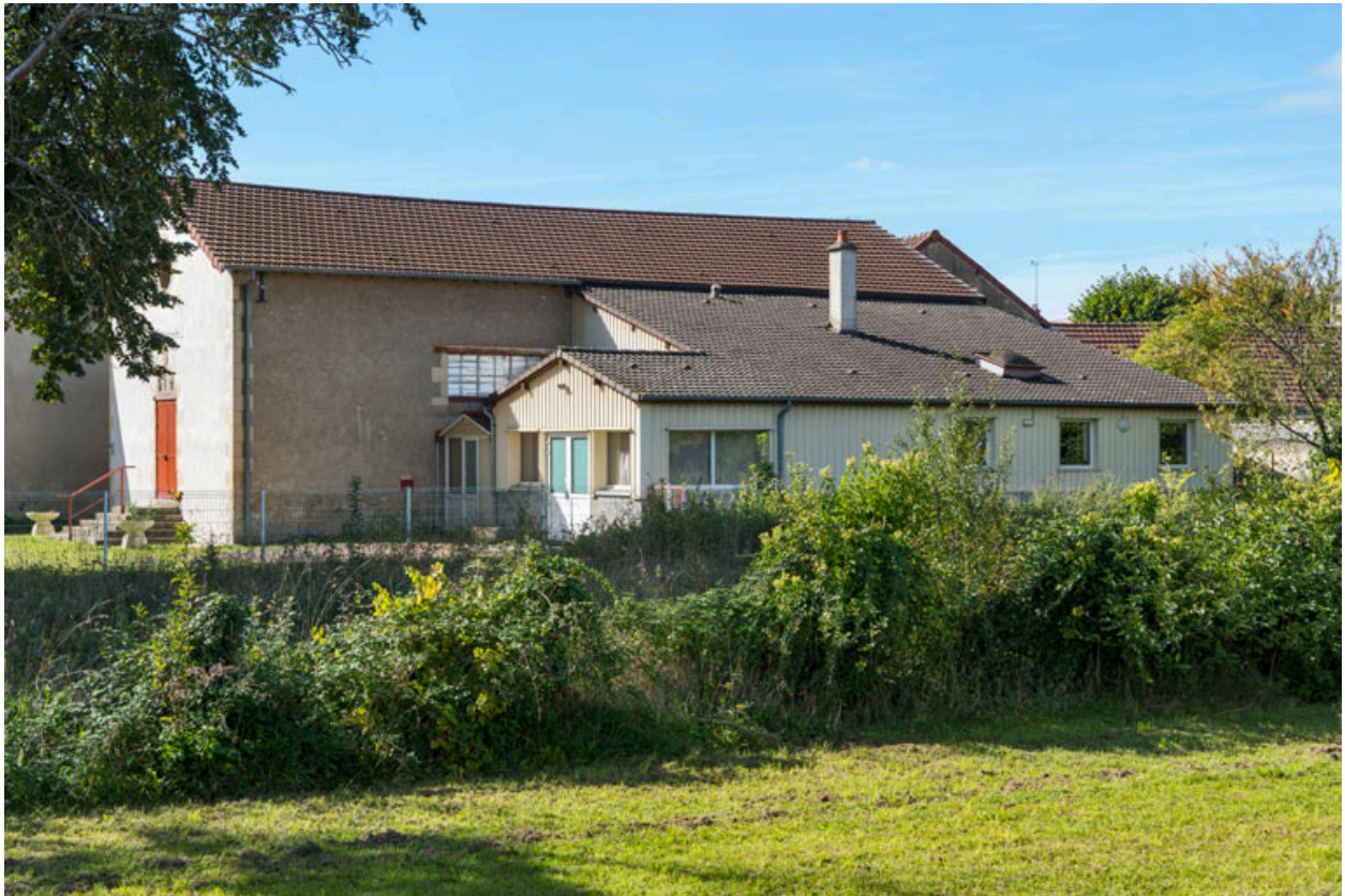
Façade latérale droite, de trois quarts gauche.
