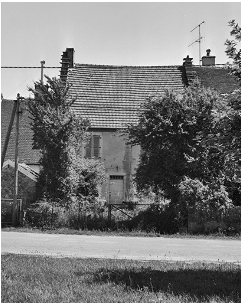
Ferme cadastrée 1960 AI 25 : vue d'ensemble.
