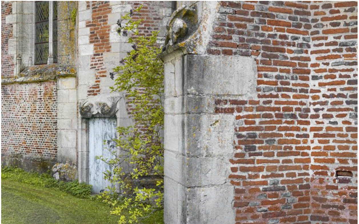
Porte de la tourelle d'escalier et contrefort de la chapelle droite.
