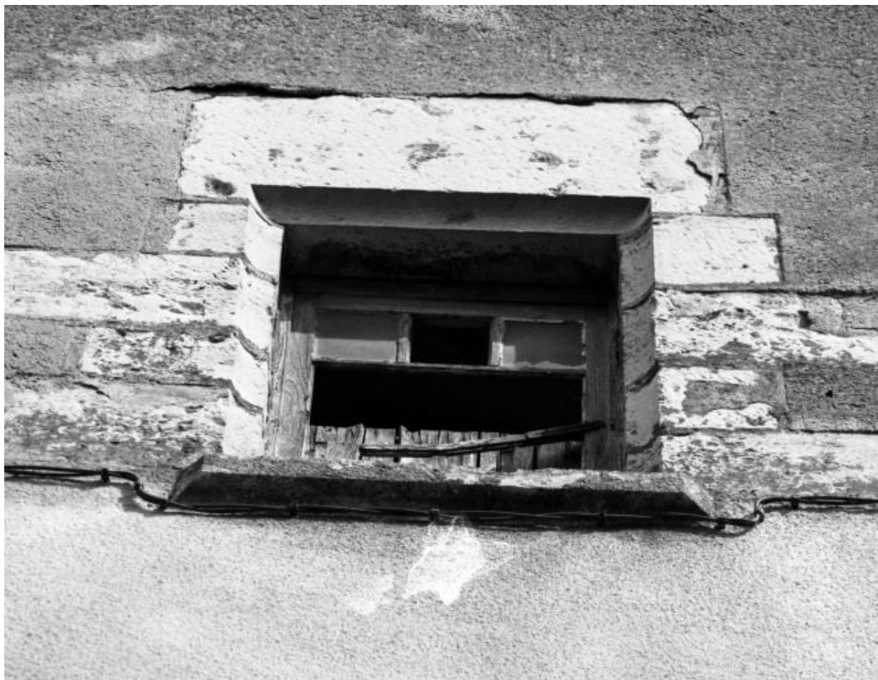
Détail : baie du pignon gauche.
