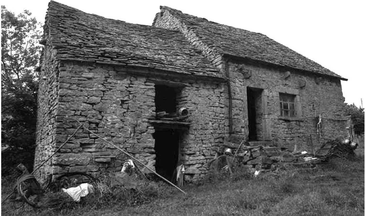
Ferme cadastrée 1960 B 108, située au lieudit La Peyrouse, datée de 1690 : façade antérieure. A noter le toit en lave et les murs pignon en pierre sèche.
