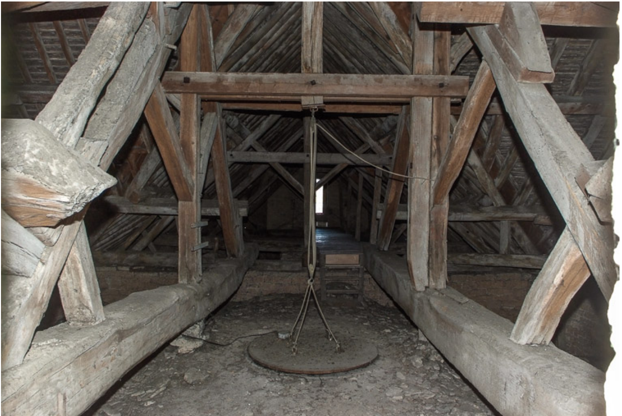
Combles, vue prise au-dessus de la croisée.
