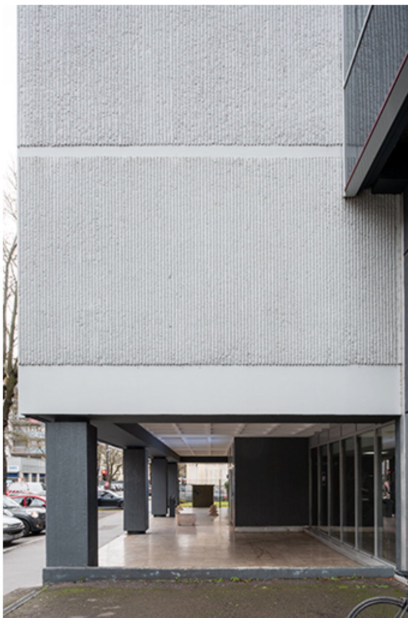
Façade nord-ouest, détail : avant-corps nord-est.
