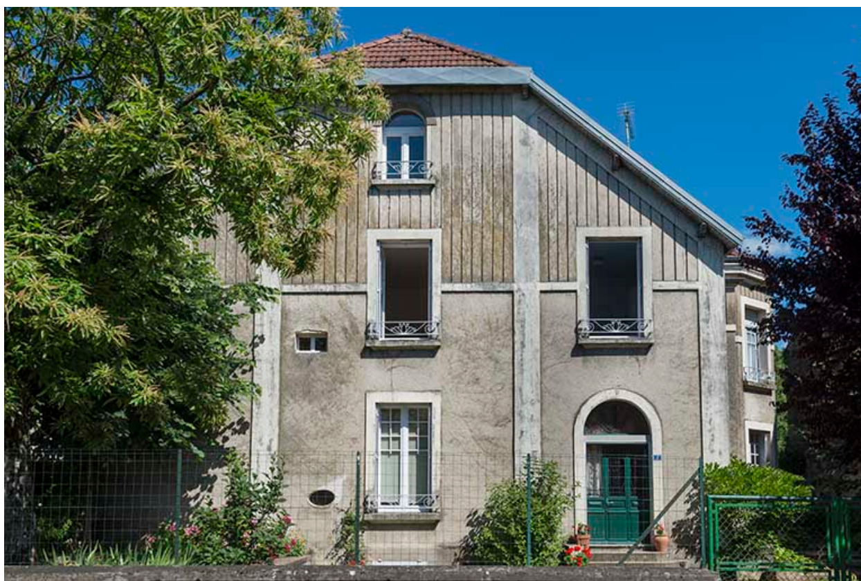
Maison côté rue de la Perception.
