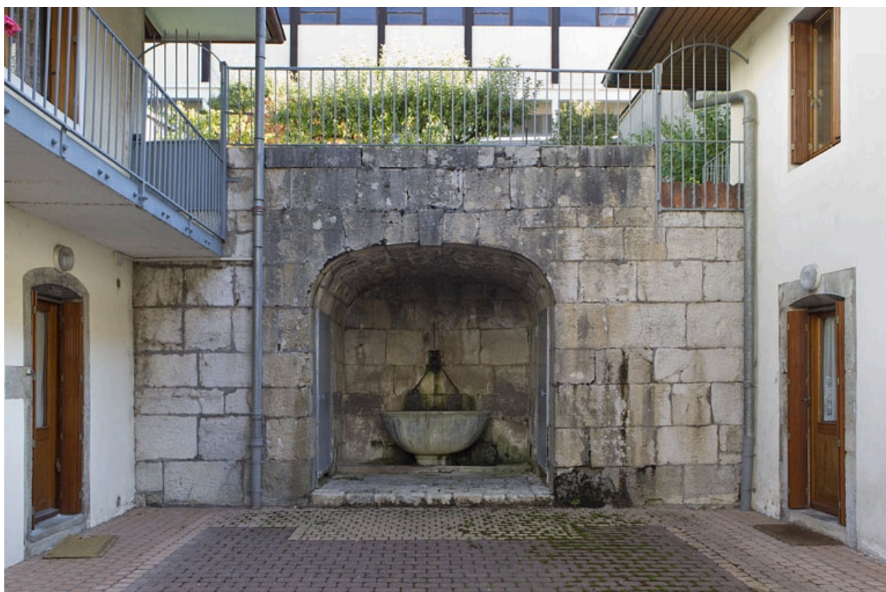
Mur de soutènement, niche et fontaine.
