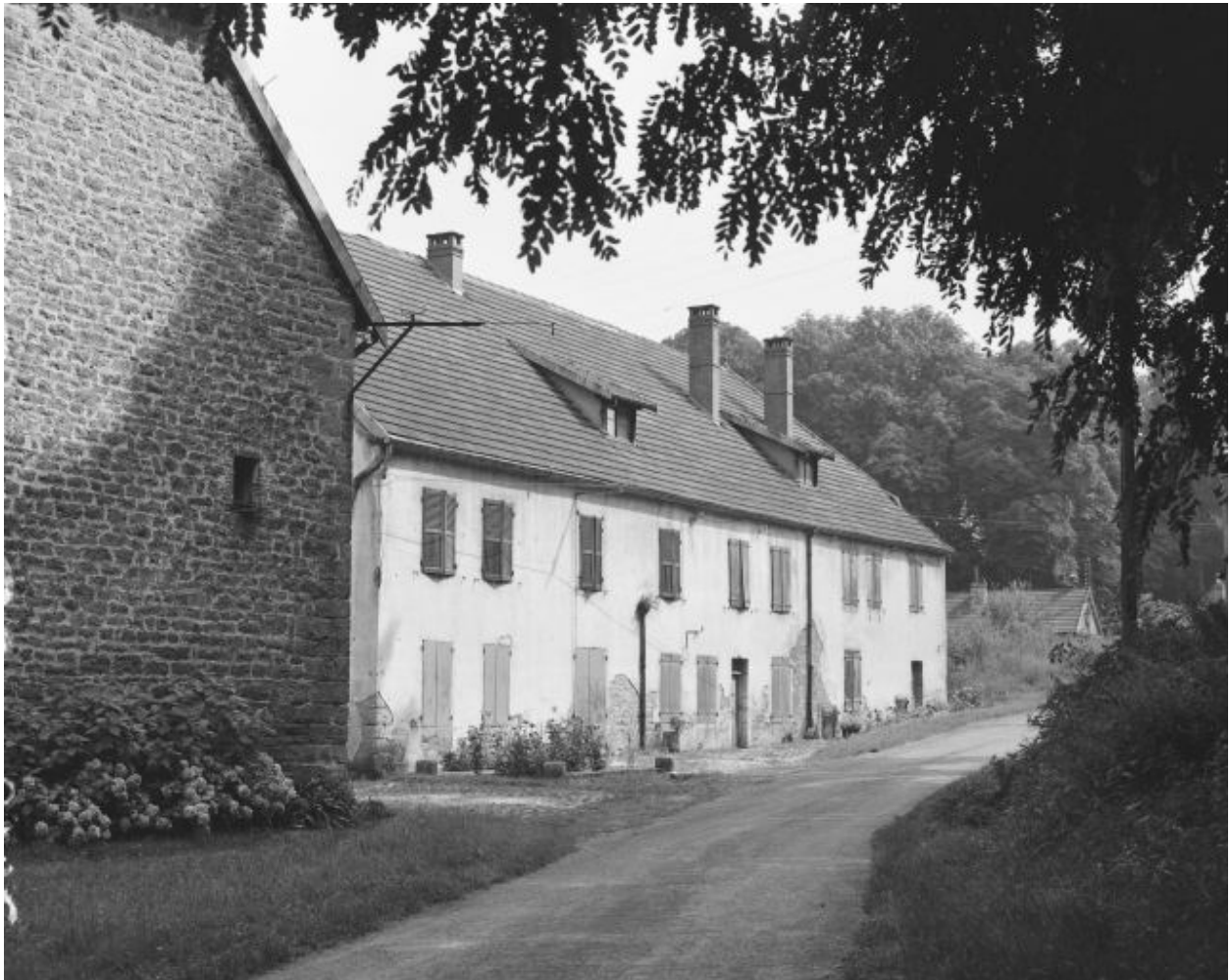
Logement patronal vu de trois quarts.
