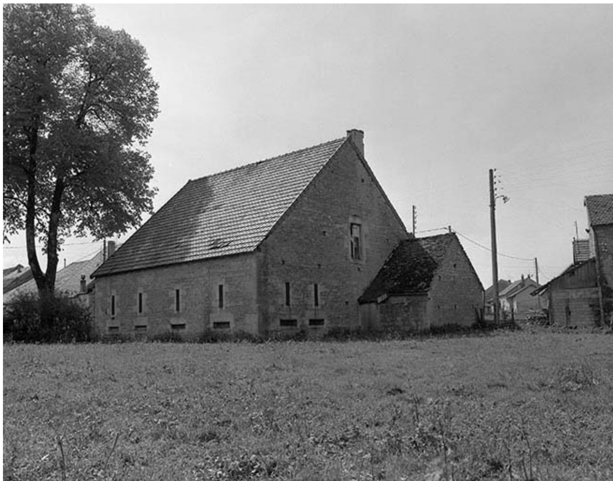
Façade postérieure et façade gauche.
