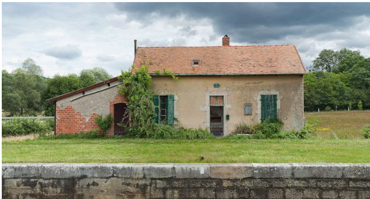
Vue de face de la maison éclusière.
