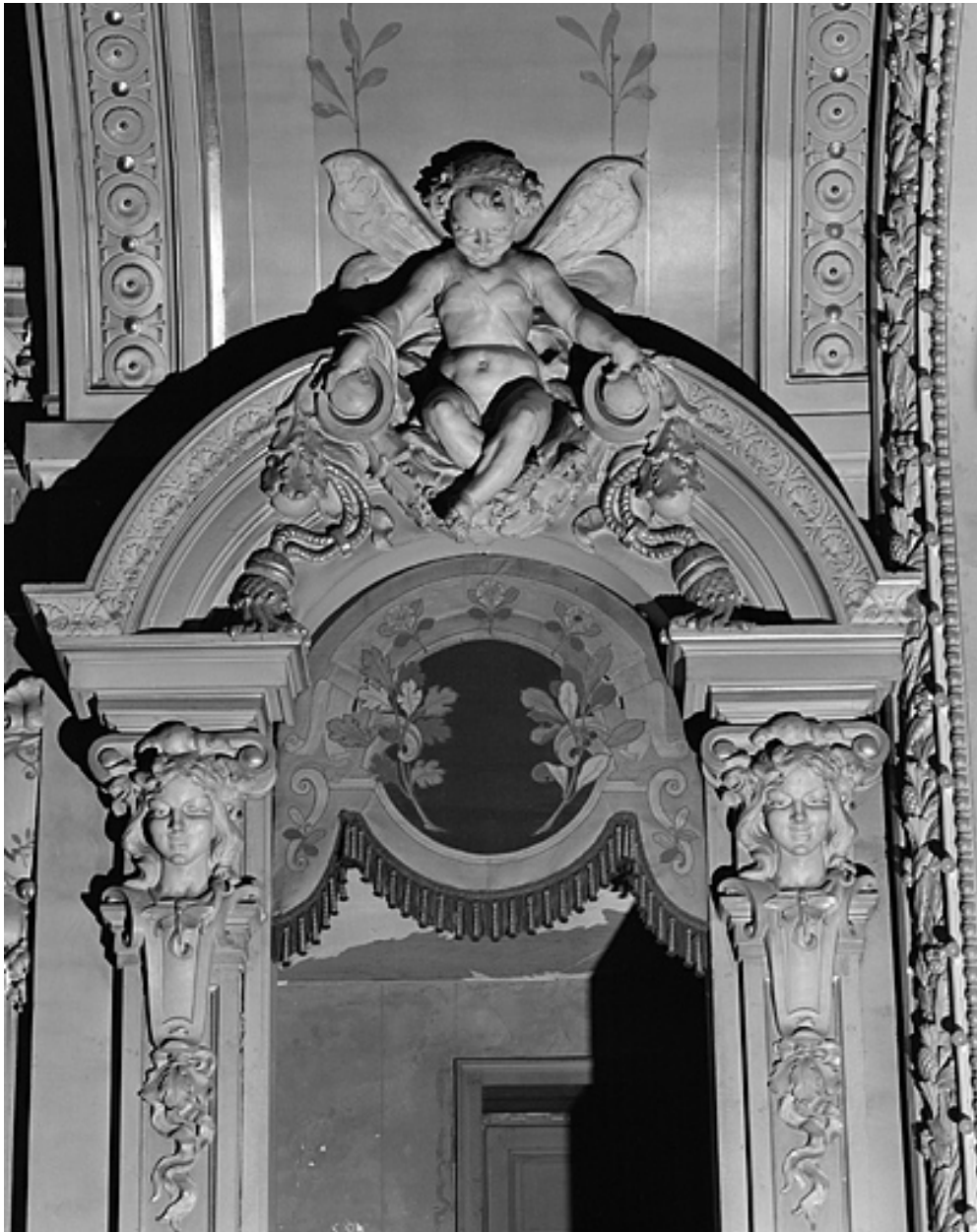
Salle, détail : couronnement des loges d'avant-scène.
