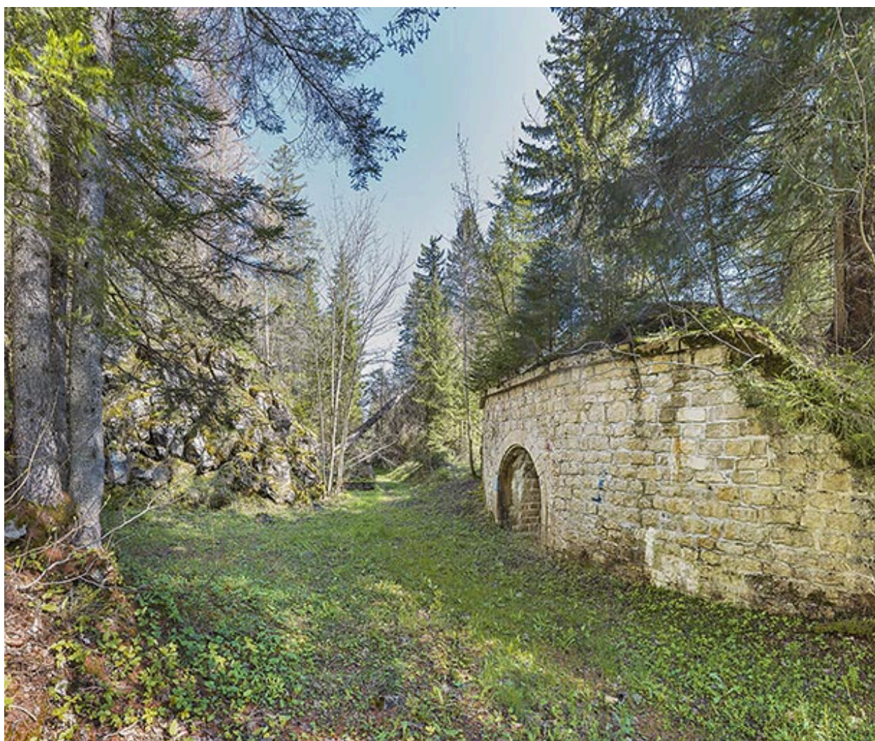
Traverse-abri à la courtine est.
