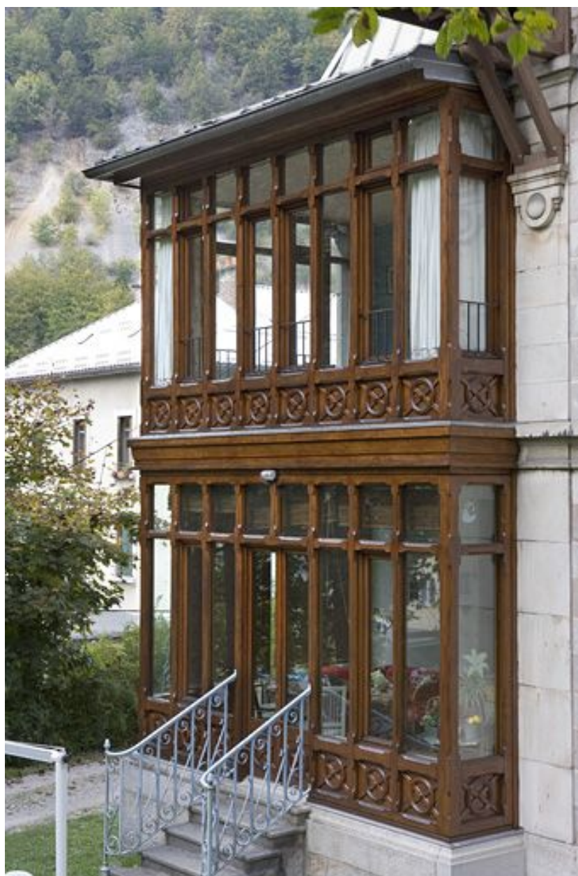
Elévation latérale droite : l'oriel.
