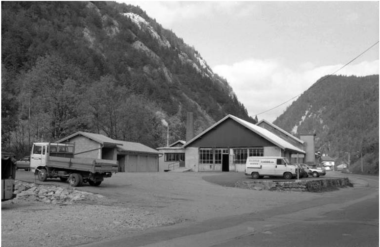
Vue d'ensemble de la façade antérieure.
