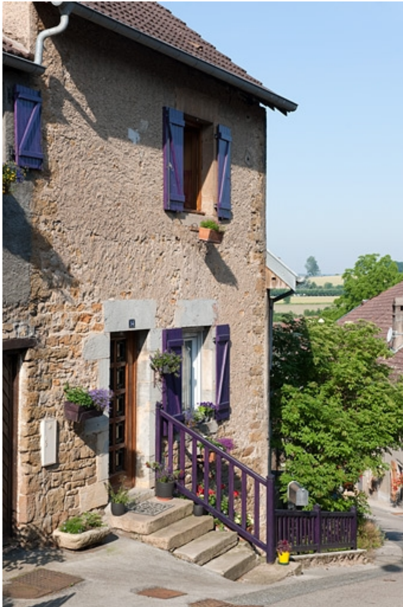
Maison au 14 rue des Gratteris (2010 AK 111).
