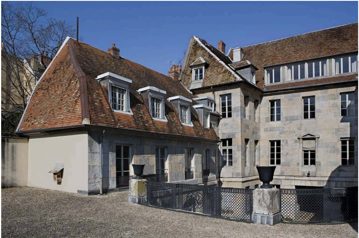
Vue de l'aile droite sur cour depuis la terrasse du jardin d'hiver.
