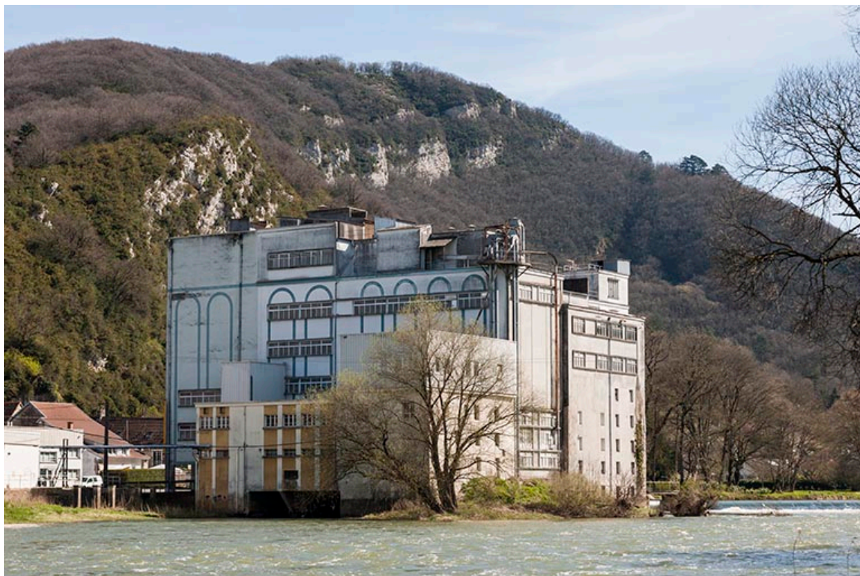
Vue de trois quarts, depuis le sud-ouest.
