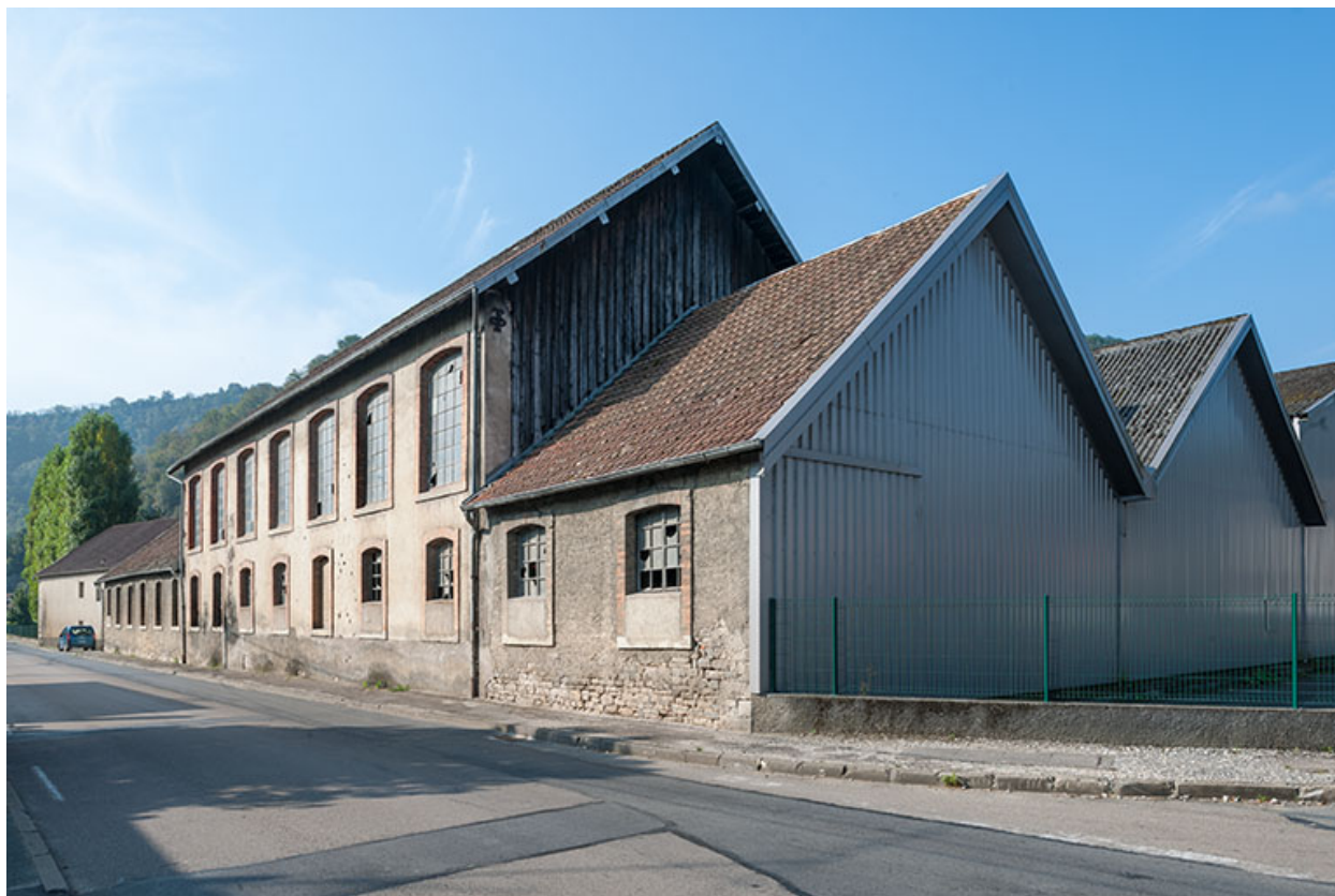
Atelier de fabrication depuis le nord-est.
